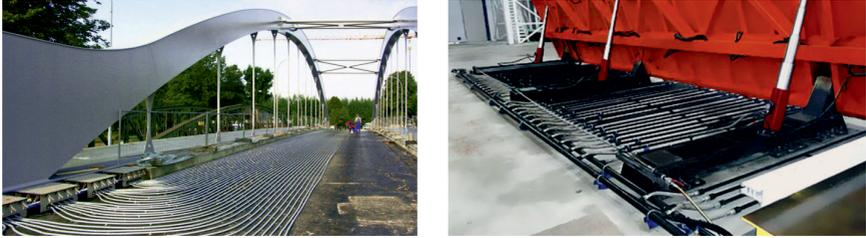
**Abbildung 1.1:** Fußgängerbrücke mit Beheizungssystem (links, [196]) und Wärmebehandlung bei der Herstellung von Betonfertigteilen (rechts, [127])
